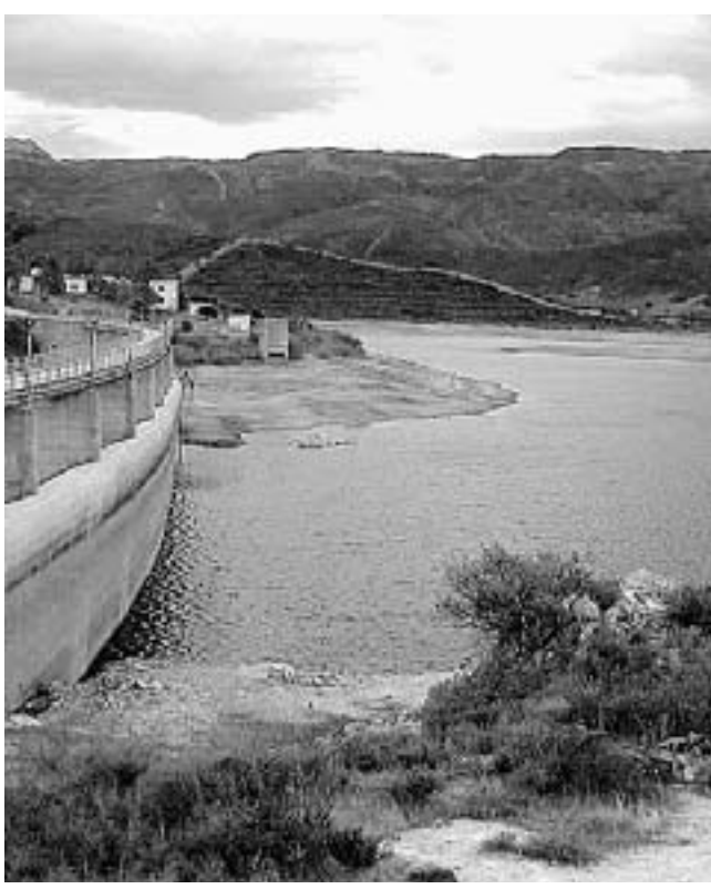
La diga Maccheronis a Torpè
